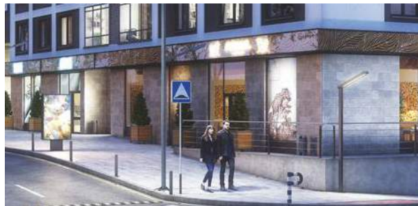
Угол б секции (помещение 8) с подпорной стенкой
